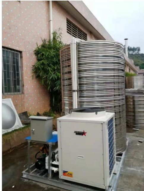
空气能热水器以其节能、舒适、环保的特点横空出世，被誉为热水器产业发展的产品。特别是近两年，空气能热水器行业进入快速成长的阶段。如今，空气能热水器被大量应用于酒店、宾馆、医院、学校、集体宿舍、美容美发、恒温泳池、休闲沐足等商用公用事业单位。家用空气能热水器也不甘示弱，发展速度非常迅速，各区域市场品牌林立。总体来说：整个空气能热水器市场蛋糕正越做越大，其潜力不可限量！由国家发改委、工信部、财政部联合发起的旨在推广达到能效标准的节能家电产品的国家“节能产品惠民工程”5月16日提出，6月14日空气能热水器企业入围名单公布。分体式空气能热水器包括主机和承压保温水箱，主机与水箱分开，运输、安装较为方便。广州剪叉式空气能一体机市场价格
