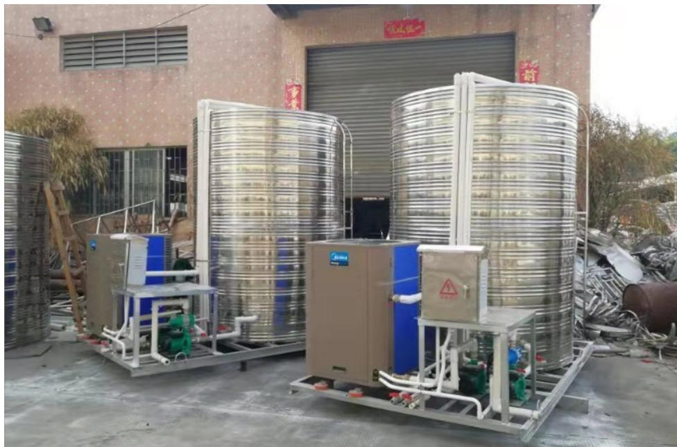
实际上大家可以把空气能热水器看做是一台空调。因为它的原理确实和空调有些相似，都是利用氟介质和压缩机来实现热量搬运，只不过空调是将空气中的热量运走，实现降温。而空气能热水器则是将空气中的热量收集起来，用来热水。所以普通的空气能热水器和空调一样有一个室外机，当然现在也有不带室外机的一体式空气能热水器。那么空气能热水器是如何做到一度电当四度用的呢？主要原因在于空气能热水器所耗费的电能并不直接用于加热，而是用于搬运空气中的不收费热能，一般来说1千瓦的电能可以搬运3~4千瓦的热量。而普通的电热水器，就是算按100%的能量转化率来算，1千瓦的电能也只能产生1千瓦的热能，所以空气能热水器能做到比传统热水器低几倍的能耗。
