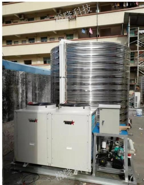
空气能一体机加热速度很快，而太阳能热水器因为冷水管太长，加热速度有点慢，往往2-3个小时才能加热成功。不仅如此，两者对于外界温度的要求也大不相同。低温型空气能一体机可以在零下30℃的环境上运行，装在北方地区的室外也完全不成问题。而太阳能热水器遇到低温还可能出现真空管结冰，冻裂的现象。耗电量第四个要对比的是两者的使用成本，也就是耗电量。夏天的时候，毫无疑问是太阳能热水器耗电量更低，因为它吸收阳光就可以产生热水，只有
